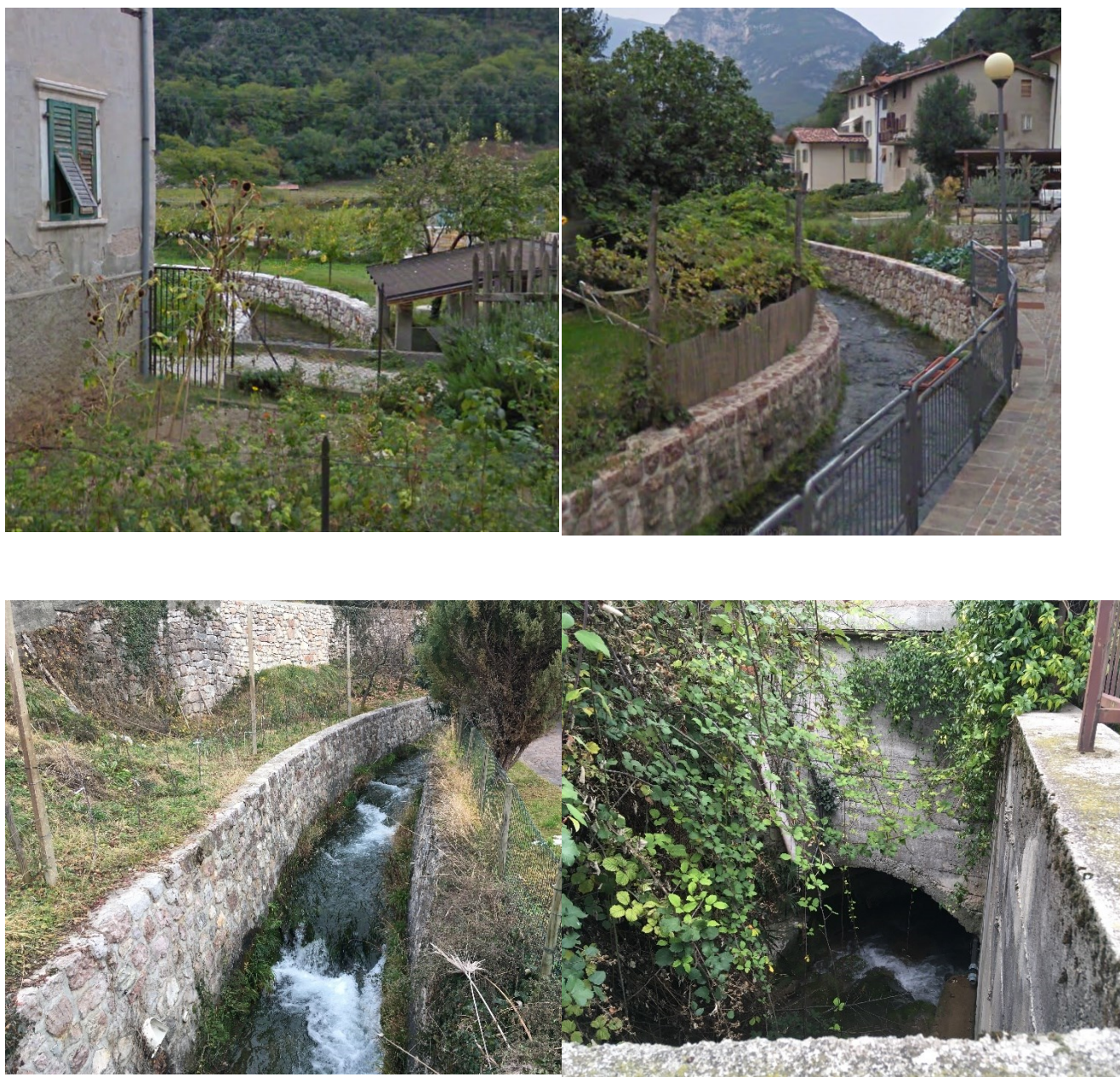
Figura 42 Tratti tombati e a cielo aperto del canale Rimone lungo il paese di Padergnone
