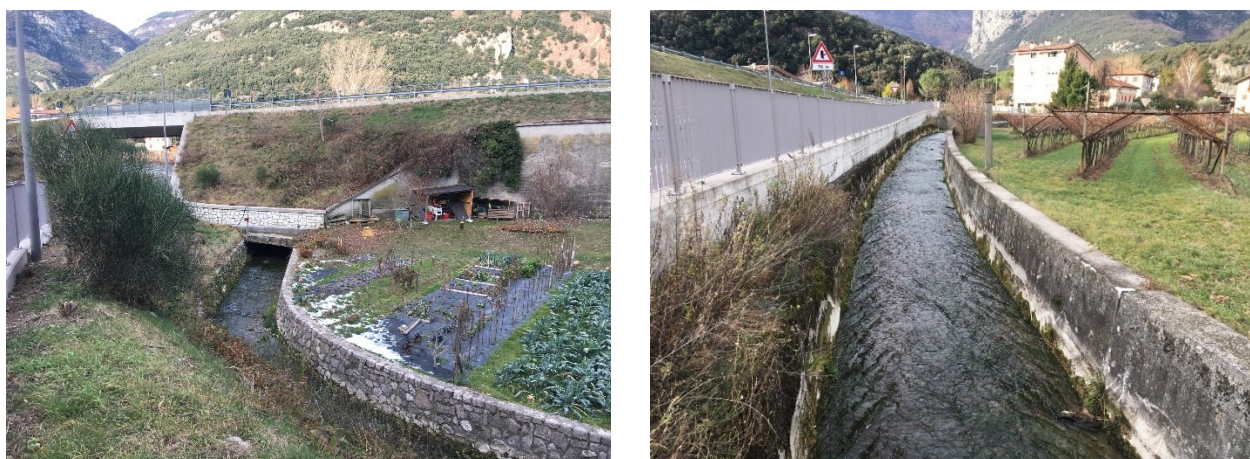
Figura 43 Tratto di valle della roggia di Padergnone. A sinistra lo scatolare sottostante la SS45Bis, mentre a destra l'ultimo tratto prima dell'immissione nel lago di Santa Massenza
