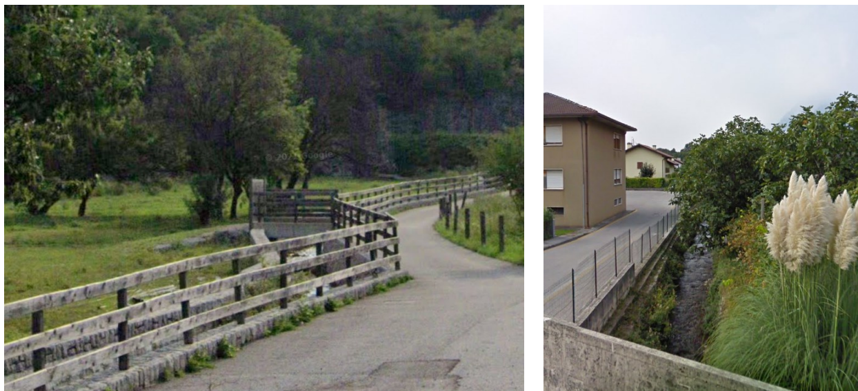
Figura 40 Roggia di Padergnone lunga la SS45Bis a monte di Vezzano a sinistra e roggia di Padergnone nel paese di Vezzano a destra
